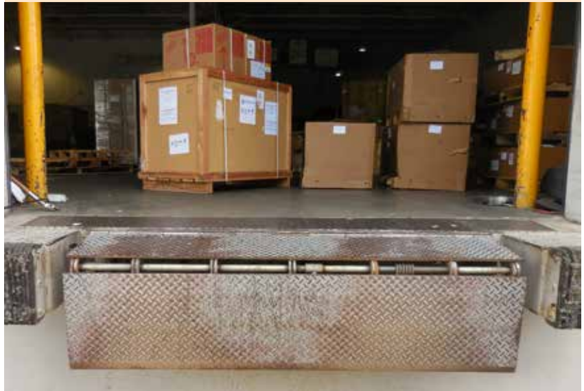
La sustitución del equipo de muelle obsoleto y desgastado, como los parachoques y puertas de carga, trae mejoras inmediatas en la eficiencia a las operaciones del centro de distribución.
